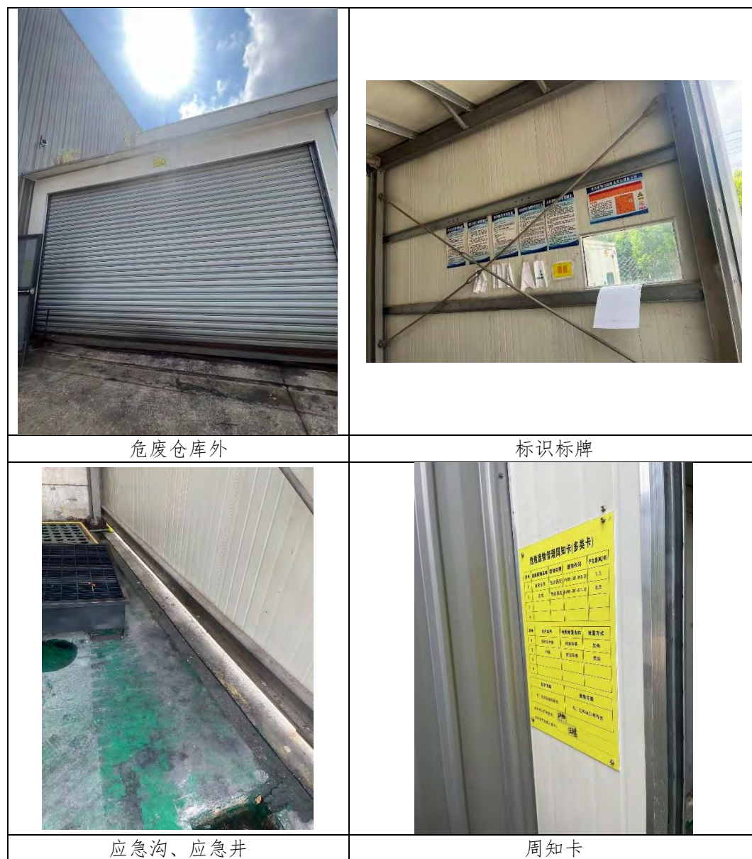
图 3-5 固废仓库现状照片
